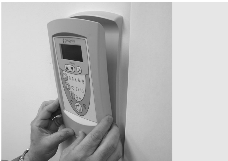
صورة 38 تثبيت لوحة التشغيل إلى حامل التثبيت
